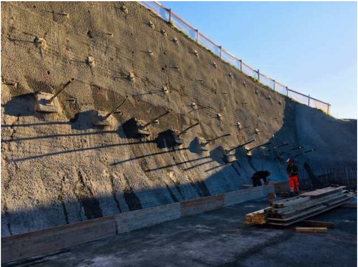
Bild: Nagelwand Baugrube Reservoir Schlatt
