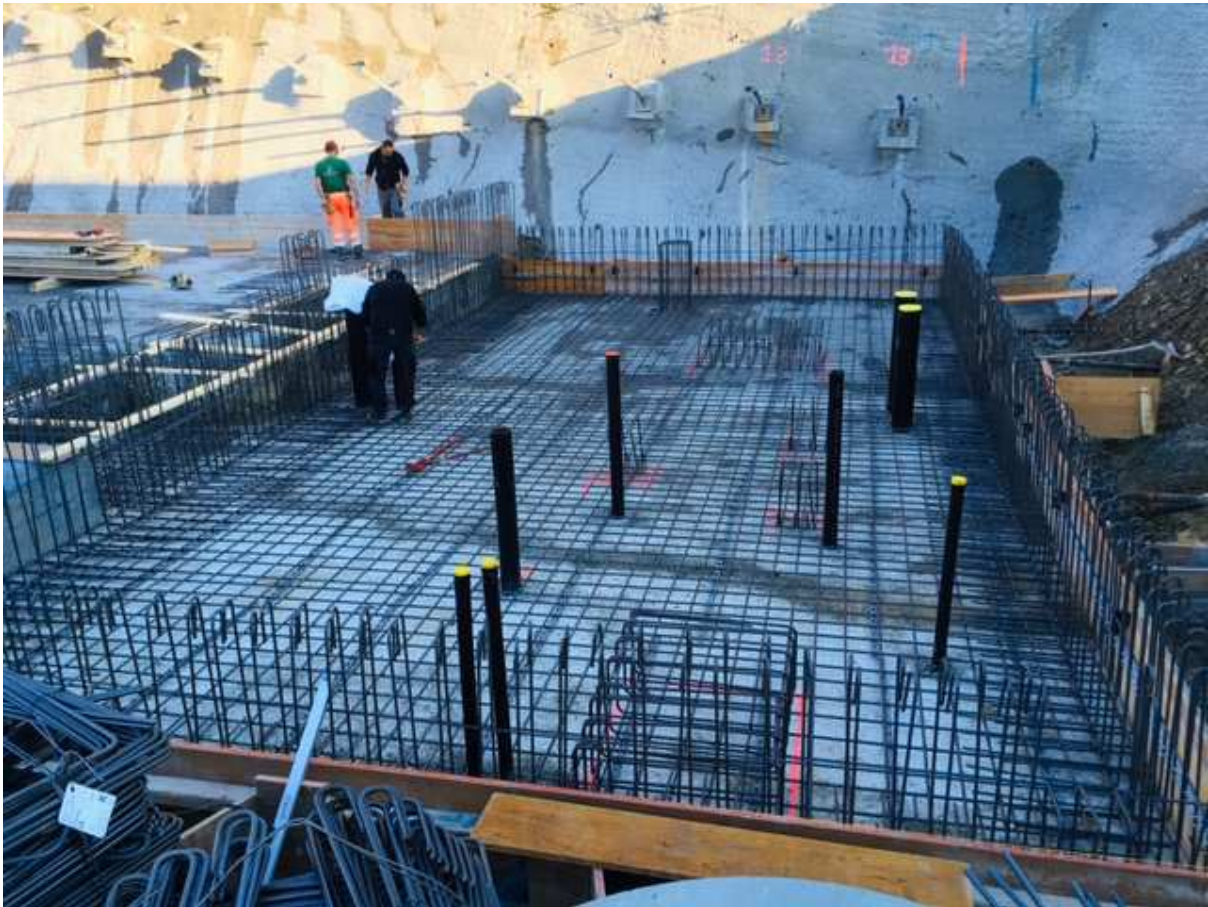
Bild: Armierung Bodenplatte Reservoir Schlatt
